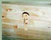
金物取付のための高度な欠込み加工
