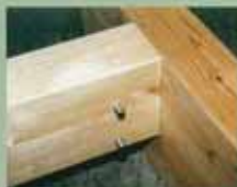
ドリフトピンによる引き寄せ密着接合
